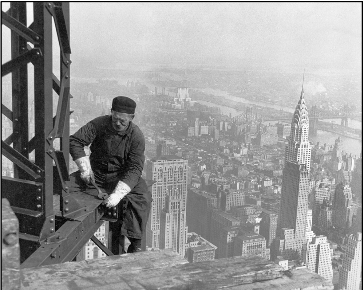
Ouvrier travaillant (sans sécurité) sur la structure métallique de l'Empire State Building (1930) [photographie de Lewis W. Hine]
